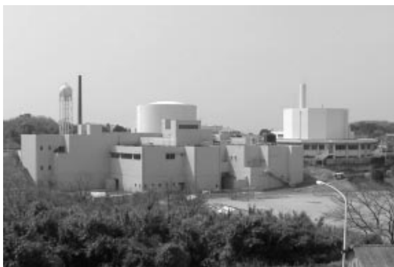
イノベーションリサーチラボ棟（左手前）
